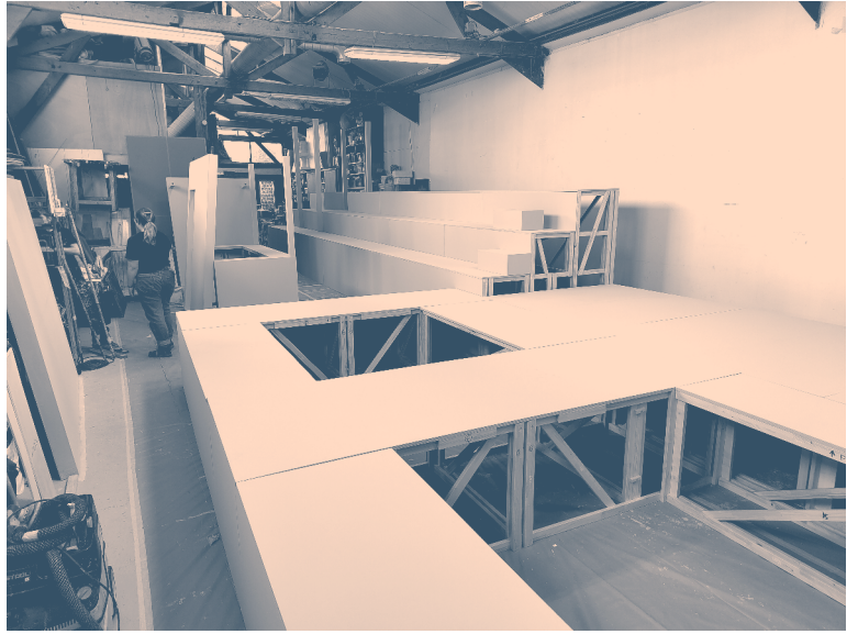
1 Construction des praticables de Palombella Rossa . Ateliers de la MC93, juin 2024. Crédit Maurizio Moretti.
